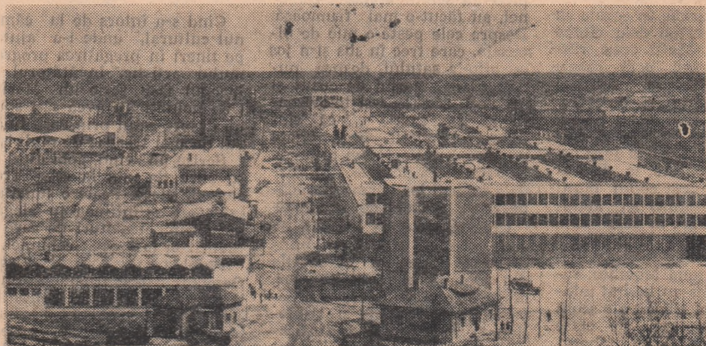
Vedere generală — C.I.L. Pitești.
