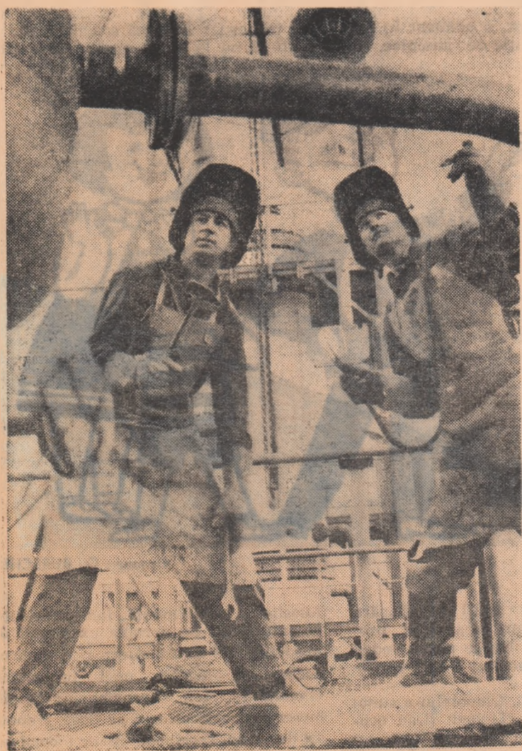
Acești doi tineri, sudori destoinici, muncesc la construirea Combinatului de îngrășăminte azotoase Tg. Mureș.
