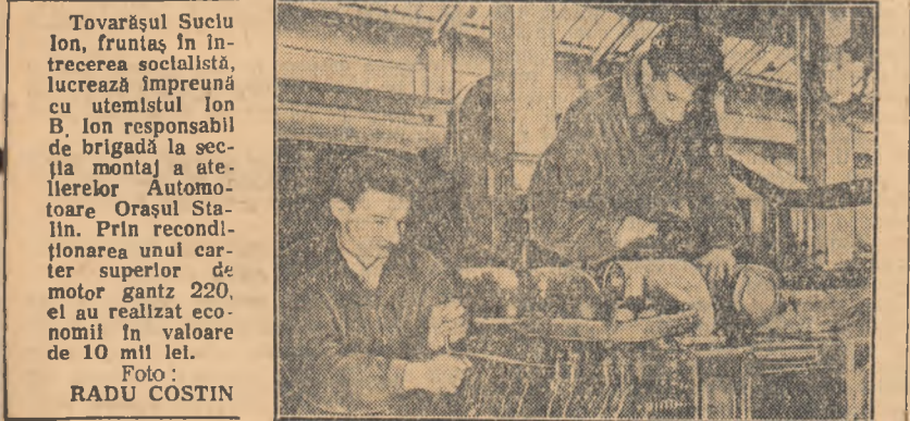
Tovarășul Sucu Ion, fruntaș în întrecerea socialistă, lucrează împreună cu utemiștii Ion B. Ion responsabil de brigada la secția montaj a atelierelor Automobiltoare Orașul Slatina. Prin recondiționarea unui carter superior de motor gantz 220, el a realizat economii în valoare de 10 mil lei.
