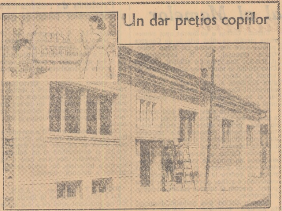
Un dar prețios copiilor Copiii muncitorilor cooperatori din Oradea au primit zilele acestea un dar deosebit de prețios: o creșă. Clădirea nouă a creșei, înzestrată cu cele mai moderne instalații, cuprinde mai multe dormitoare, săli de masă, bucătărie, baie, cabinet medical, sală de joacă, terasă etc. De asemenea, la dispoziția micilor locatari se află o frumoasă grădina cu pomi.
