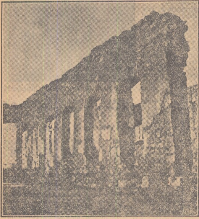
Unul din zidurile Doftanei prăbușite
