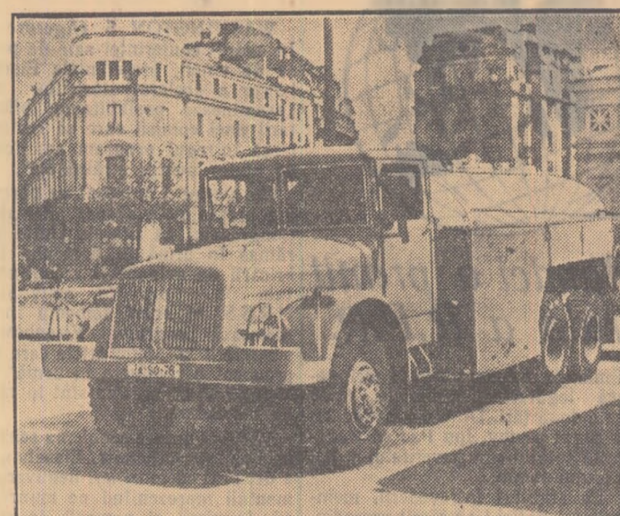
Pe străzile Capitalei, și-a făcut apariția o nouă mașină ce atrage atenția trecătorilor prin linia și mai ales prin instalațiile ei deosebite. Am recunoscut ușor în ea mașina cehoslovacă „Skoda” 708 Rok, destinată stringerii și transportării gnoanelor menajere. Ea este, după cum ne-am convins, o mașină modernă, foarte necesară menținerii curățeniei unui oraș frumos cum este Capitala noastră. „Skoda” dispune de aparate de descărcare automată a vaselor de colectat gnoane, instalații pentru absorția completă a miorosurilor și un sistem de comprimare aflat în interiorul rezervorului cu o capacitate de 6800 kg.
