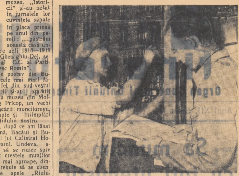
Termocentrala „Steaua roșie” din Singeorgiu de pământ. Șeful secției electrice Kemeș Ștefan și electricianul Lift Mihai verifică circuitele secundare ale grupului nr. 4. Foto AGERPRES
