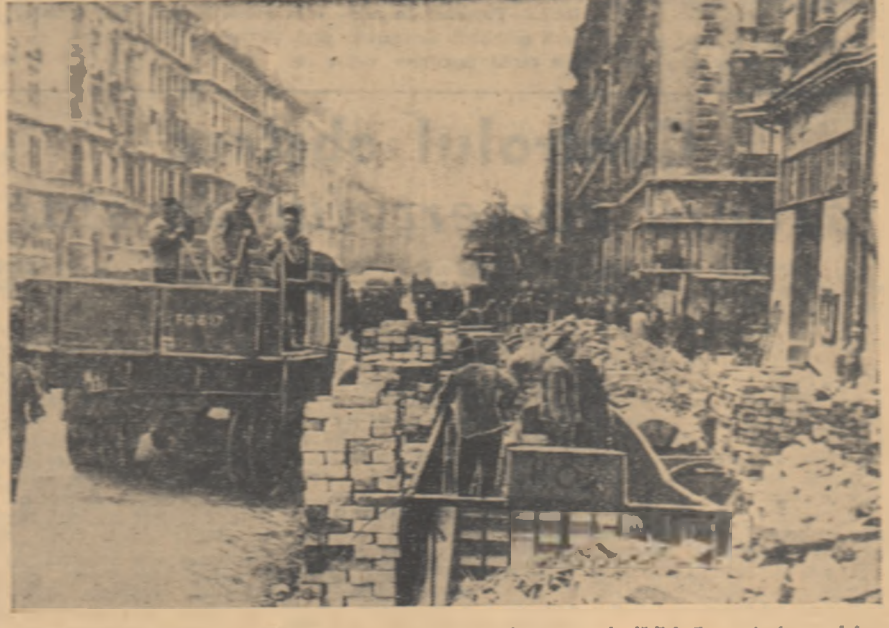
BUDAPEȘTA AZI: Muncitorii unguri lucrează la refacerea unei clădiri din centrul orașului
