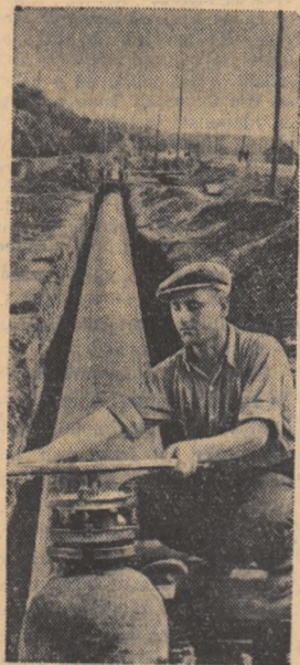
In orașul Iași se instalează conducta de aducțiune a apei de la Prut pe distanța de 19 km.
