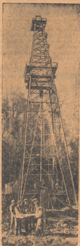
Inginerul geolog Ionijă Vasile de la întreprinderea de foraj Zemeș împreună cu ing. Cojocaru Cristian, șef adjuncțat al secției a-7-a Zemeș și ing. Gh. Sebatoș, șeful echipei de carotaj radioactiv Ploiești cu secția permanentă la Zemeș, urmărind rezultatele înregistrate de diagrama de carotaj radioactiv la sonda 4069, cea de-a 8-a sondă forată cu turbina la adâncime mijlocie.
