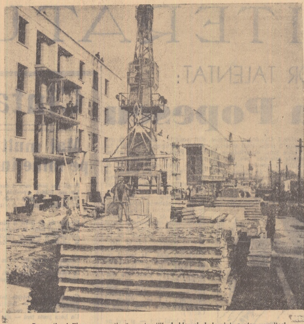
Pe șantierul Floreasca continuă construcțiile de blocuri de locuințe pentru muncitori
