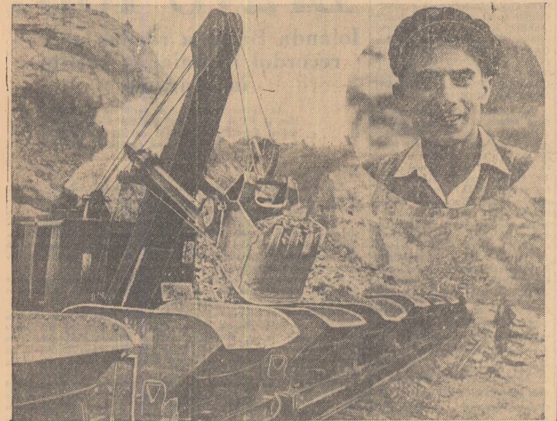
Escavatoristul Aurel Crişan a învăţat meseria la mitele de fier de la Teluc. După satisfacerea stagiului militar el s-a reintors la escavatorul pe care l-a îndrăgit
