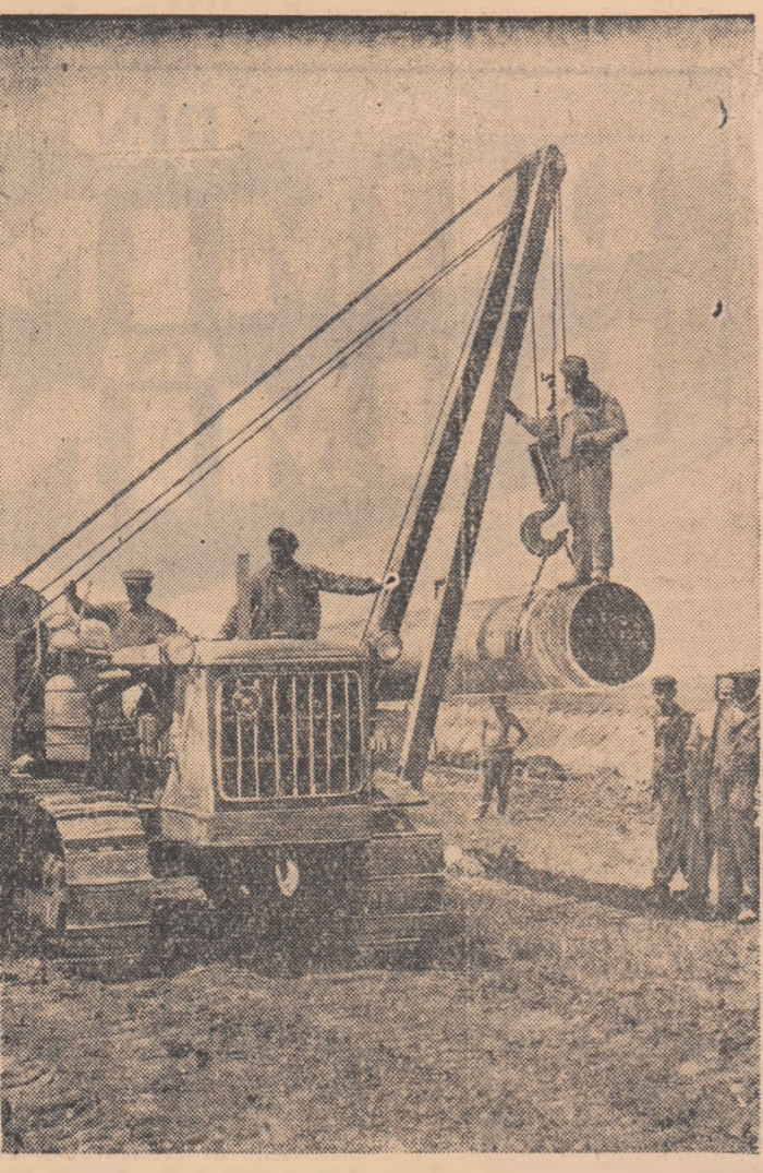
Un nou crimpel din marea conductă de gaz metan e instalat
