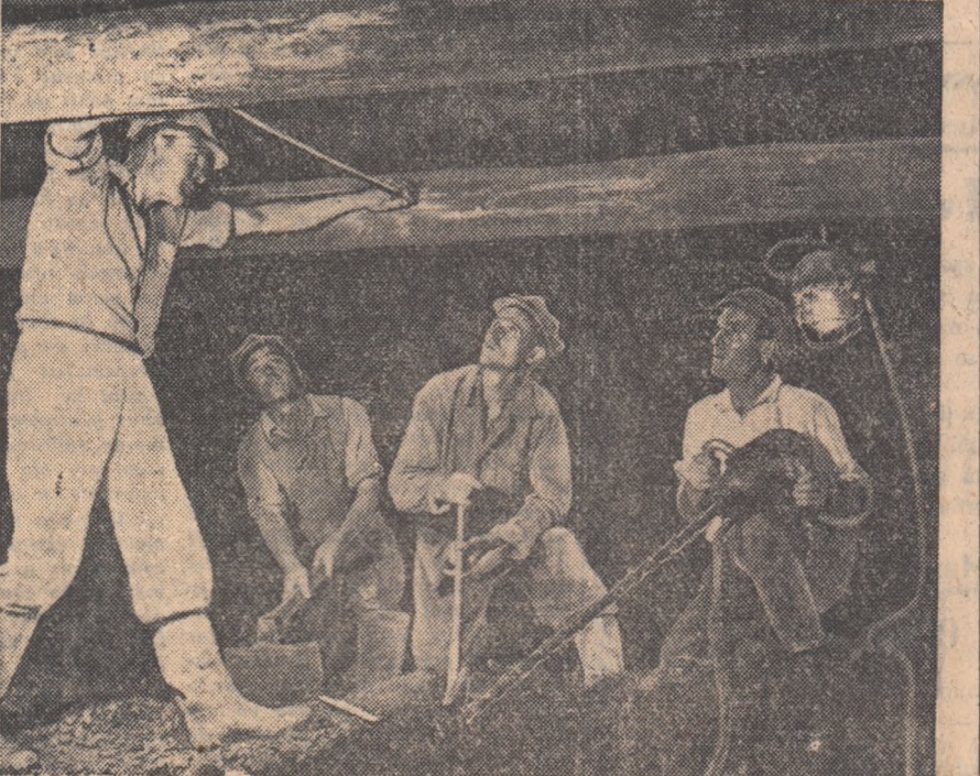
În cadrul exploatarei miniere Vulcan s-au deschis de curind la Paroșeni două noi galerii de exploatare a cărbunului cosificabil. În fotografie: Brigada minerului Iancu Octavian luînd măsuri pentru armarea frontului de lucru.
