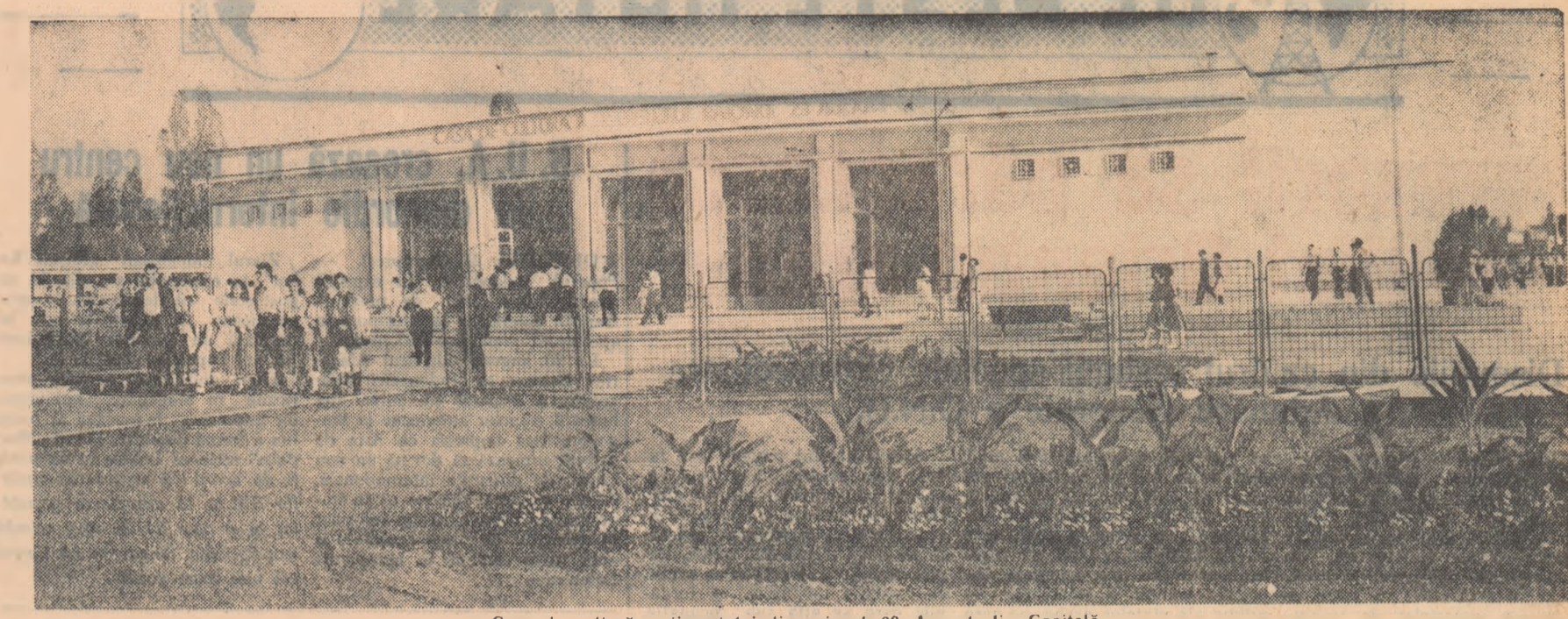
Casa de cultură a tineretului din raionul 23 August din Capitală
