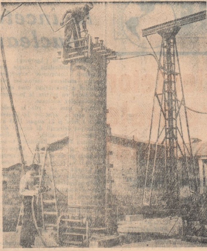
Muncitorii de la Institutul de cercetări pentru construcții, materiale de construcții și lemn, lucrînd la un tub de presiune din beton precomprimat, care înlocuiește cu succes tubul de metal supus coroziunii.
