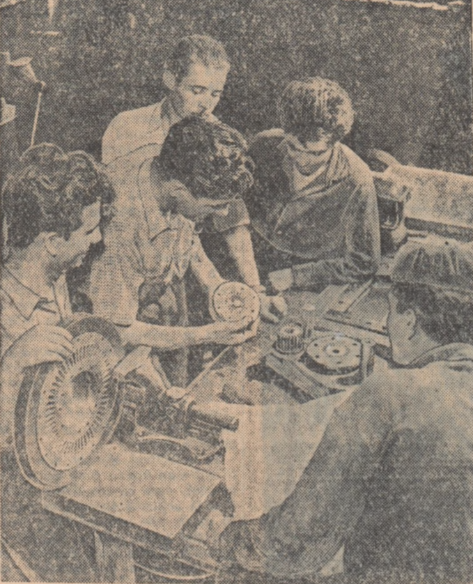
La o matrită, s-a uzat orificiul de tăiere. Normal, înainte, din această prilej, se confecționa o altă matrită. Brigada de rentabilitate condusă de maestrul șef Dumitru Marin, din secția matritelor, a venit cu ideea de a utiliza și înlocuiri orificiul de tăiat uzat. Ideea aplicată în practică, a adus uzinei o economie de 5.000 lei.
