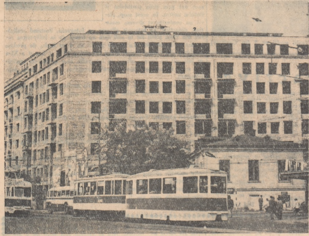
Pe bulevardul Magheru, lingă cinematograful Patria, s-a ridicat, vîzînd cu ochii, o nouă construcție. Creștea vertiginos numărul locuințelor pentru oamenii muncii din Capitală. Foto: N. STELORIAN
