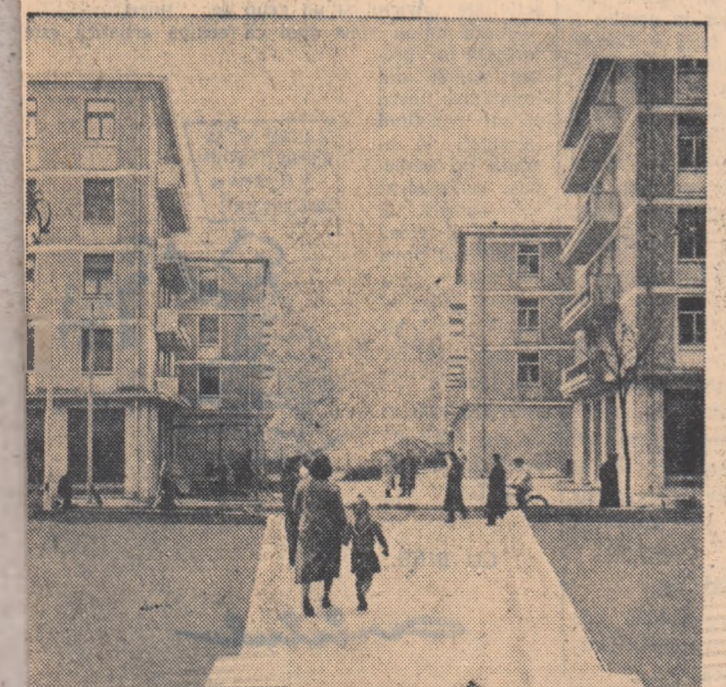
Noile blocuri din centrul orașului Galați, construite pe vechile ruine lăsate de fasciști. Foto: I. MIHALACHE
