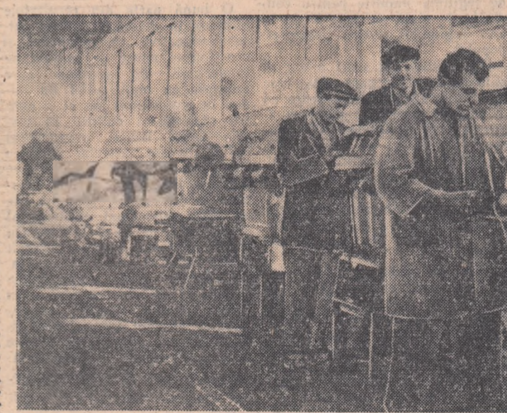
Produsele uzinelor „Mao Tze-dun” din Capitală sînt cunoscute peste hotare. Printre produsele exportate sînt: mori de ciment pentru China și Vietnam, unități de pompaj pentru extracția șijeului pentru Argentina etc. În fotografie: În secția mecanică-reducătoare, lăcătușul Pompiliu Tăulescu, Ștefănică Stanciu și controlorul Nicolae Strungaru făcînd ultimul control la un lot de reductoare pentru unitățile de pompaj destinat exportului. Sînt cunoscute peste hotare. Foto: AGERPRES
