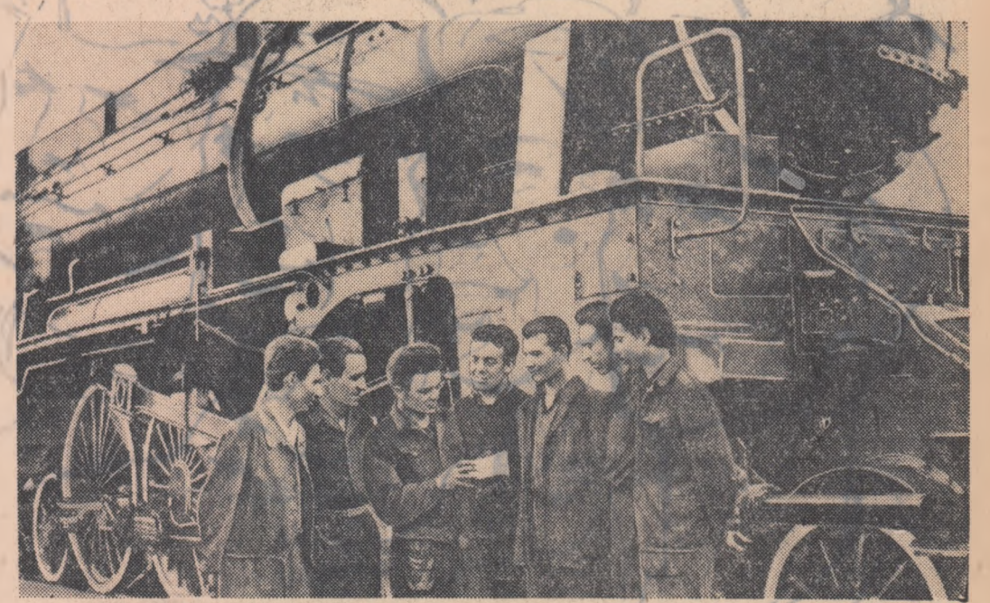
Tinerii din brigada din secția I-a țevărie-montaj de la Atelierele C.F.R. „16 Februarie”-Cluj condusă de utemistul Martin Birta, în cîntea zilei de 1 Mai, au contribuit prin munca voluntară la reparația unei locomotive care a fost realizată peste plan.
