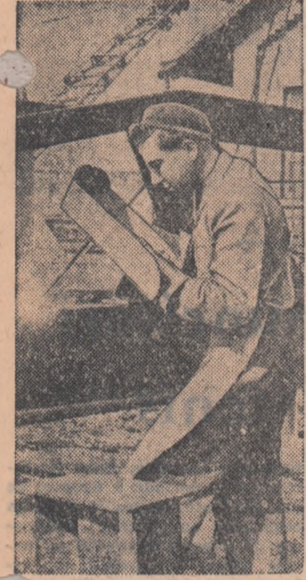
Utemistul Cirstea Marin de la Intreprinderea de poduri metalice din Pitești se situează printre sudorii fruntași ai întreprinderii. Iată-l în fotografie lucrînd la sudarea unui pod rulant.
