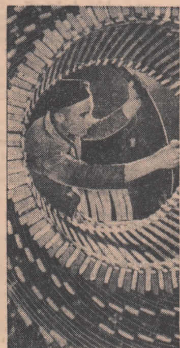
Electricianul Nicolae Rău, din secția motoare electrice a Combinatului Metalurgic Reșița, lucrând la bobinarea statorului de 3000 kw destinat exportului în R. P. Chineză.
