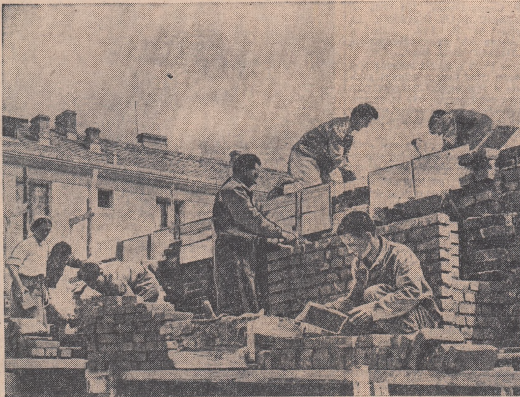
Studentii anului I al Institutului de construcții din București sînt în practică. Ei lucrează la construirea unui bloc în cartierul Floreasca
