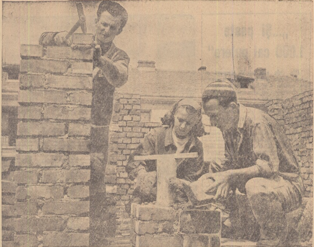
Peste puțin timp blocul la care lucrează studenții de la Institutul de construcții din București în cadrul practicii de vară va fi gata. În fotografie studenții Tatmir Iulian, Bogdănescu Sorin și Iancu Lucia lucrând la construcția acestui bloc.
