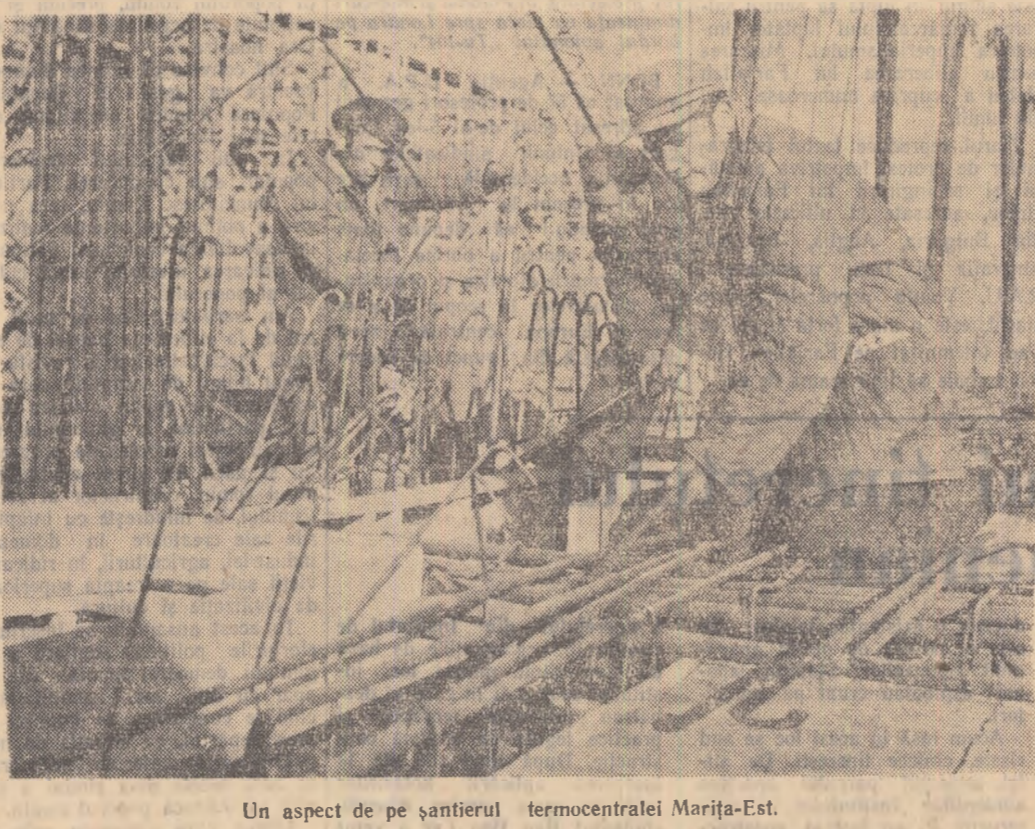
Un aspect de pe șantierul termocentralei Marița-Est.
