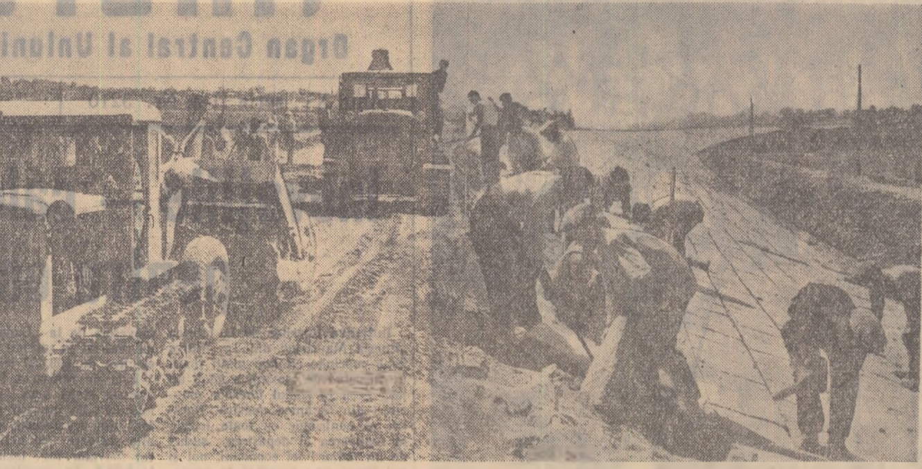
Pe șantierul de îmbunătățiri funciare de la Căldăruș, regiunea București, tinerii lucrează la consolidarea digului de stăvîlire a apelor
