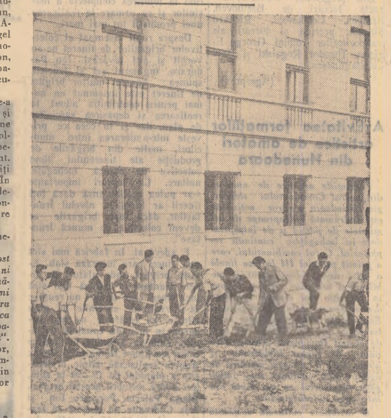
Brigada utemistă de muncă patriotică a studenților din anul II al Facultății de construcții din Iași, condusă de secretarul organizației U.T.M. de an întimpină prin muncă deschiderea anului universitar. Iată-i pe membrii brigăzii lucrînd la taluzarea terenului în jurul unuia din corpurile Institutului
