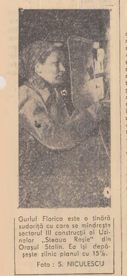
Gurlu Florica este o tânără sudorită cu care se mândrește sectorul III construcții al Uzinelor „Steaua Roșie” din Orășul Stalin. Ea își depășește zilnic planul cu 15%.
