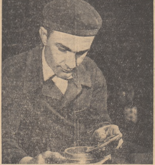
Care chiulosa schimbătorului de viteză — s-a întrebă întotdeauna Stanciu, — n-ar putea fi abținută prin turnare în loc de ștanțare? În felul acesta tabla de oțel, destul de costisitoare, s-ar putea înlocui cu fontă, iar manopera ar fi incomparabil mai redusă.
