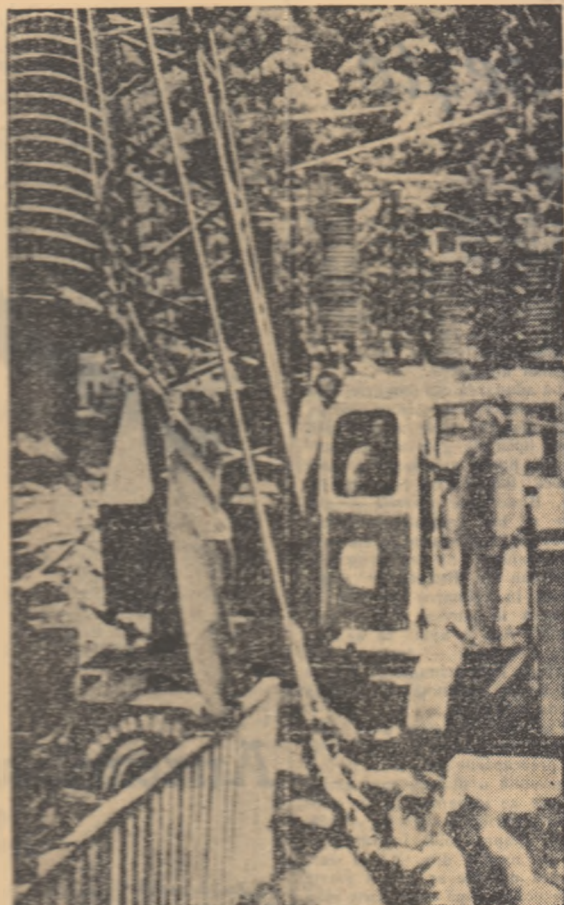
Imagina noastră vă redă un aspect din R. P. Bulgaria: se montează o substație a centralei hidroelectrice de la Pester, care face parte din sistemul hidroenergetic de la Batak.
