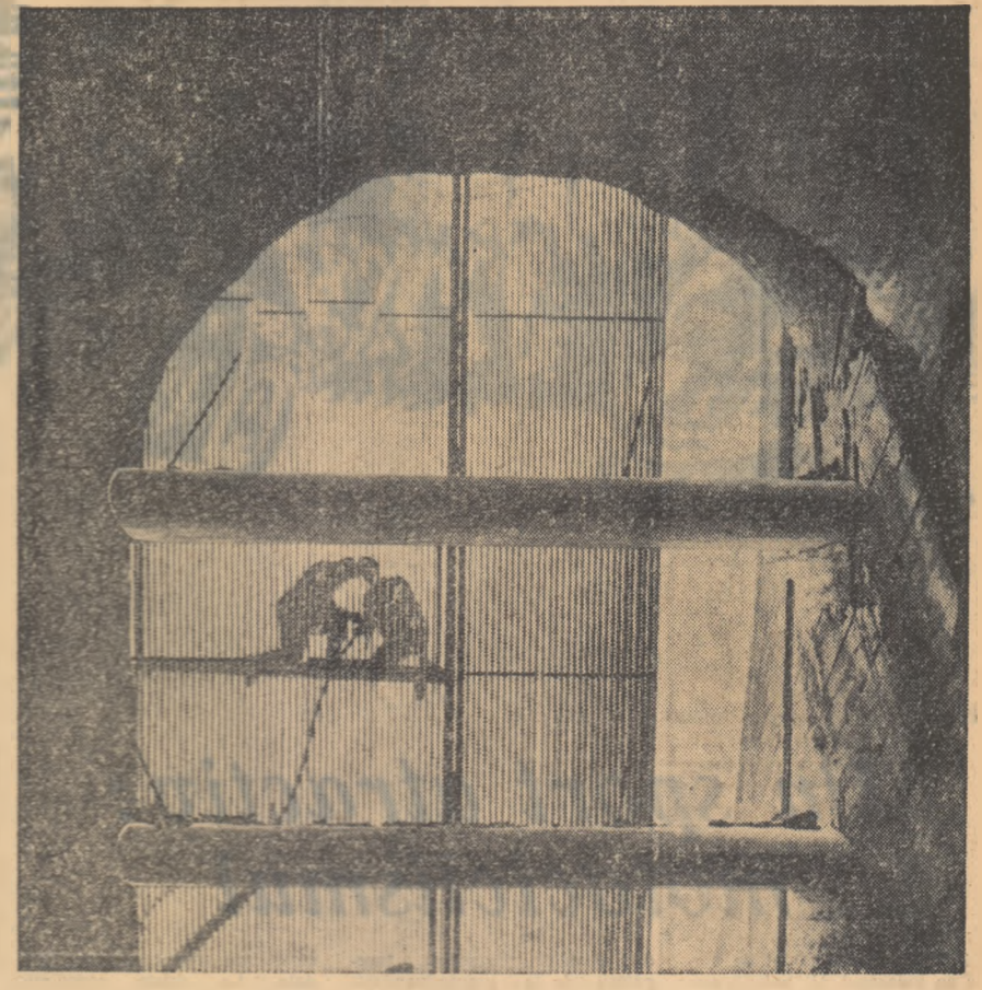
Pe șantierul hidrocentralei „V. I. Lenin”. Bicoz se montează grătarele care vor împiedica pătrunderea bustenilor sau a altor corpuri odată cu apa în tunelul de aducțiune al hidrocentralei. Foto: AGERPRES
