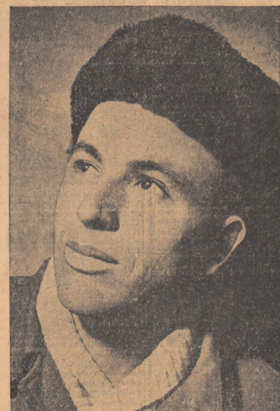
Tinărul acesta este comunistul Gheorghe Bucelea, fierar betonist la șantierul nr. 4 Onești. Inițiativa sa de a reduce consumul specific de materie primă cu 2 la sută este cunoscută astăzi de către tinerii de pe toate șantierele din Onești. Foto: P. POPESCU
