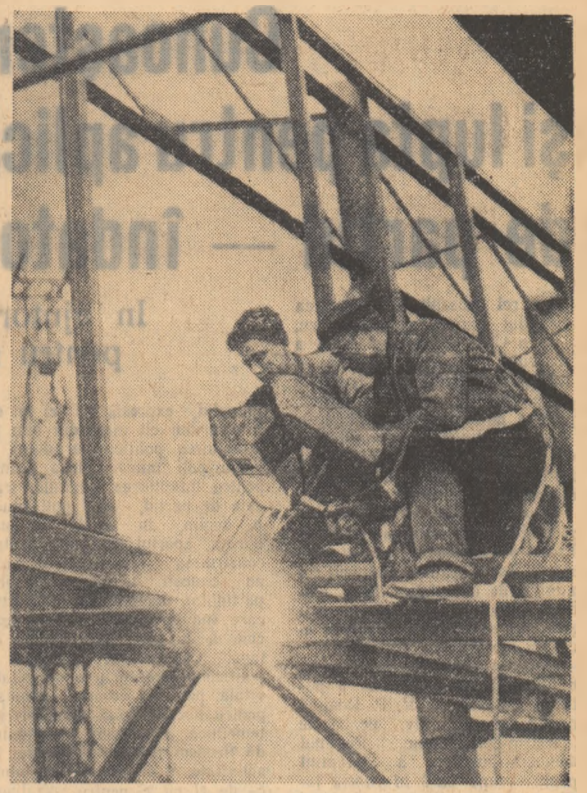
La peste 80 de metri înălțime, sudorii Bălan Ion și Dragomir Gheorghe, lucrează la sudarea fermei viitorului cuport O.S.M. nr. 4 — al tineretului de la Hunedoara
