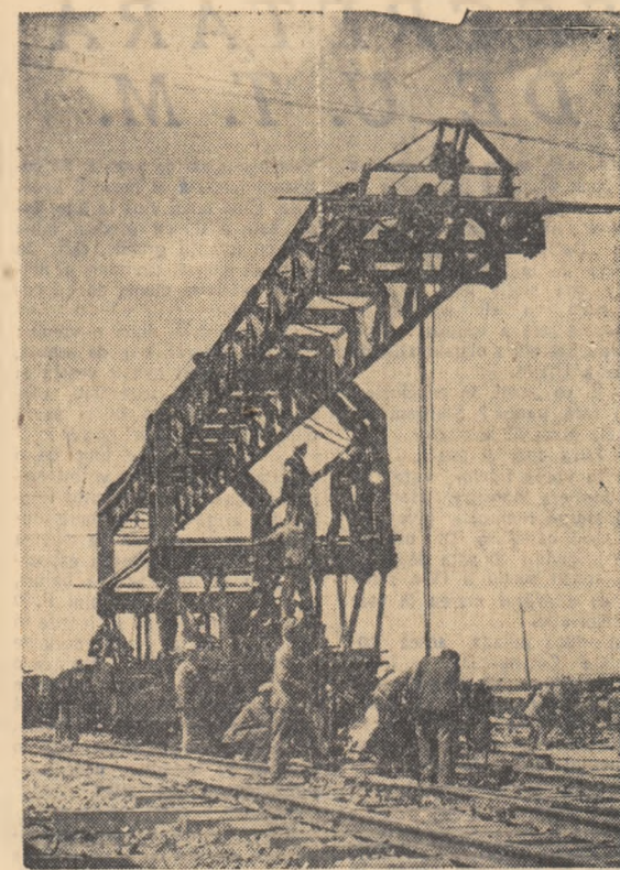
În Republica Populară Chineză se desfășoară pe larg construcția de căi ferate. Iată lucrările ce se fac în vederea construcției unei noi căi ferate în sud-vestul Chinei. Foto: CHINA NOUA
