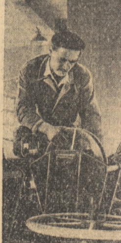
Constructorii și montorii de pe șantierele saciei derîndan a Întreprinderii Carbochim, din Cluj, grăbesc ritmul lucrărilor. În fotografie: montatorul Almas Bogdan, lucrînd la montajul sistemului de ridicare a electrolizator, în hala de topire.
