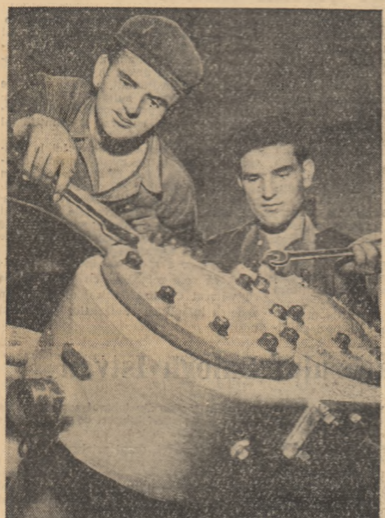
După montarea capocelor de presiune compresorului de 200.000 K. col. va fi complet gata. Iată în fotografie pe tinerii Ioan Varga și Ionosy Csaba doi din fruntașii în muncă de la întreprinderea „Tehnofrig” Cluj lucrînd la montarea lui.
