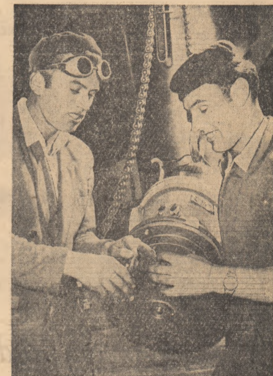
La hidrocentrala „V. I. Lenin” de la Bicaz se fac lucrări de montaj. În clișeu, montorii Nicolae Iacob și Ioan Niță, lucrînd la montarea lagrului de ghidaj al turbinei nr. 3.
