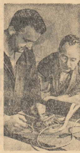
În laboratorul întreprinderii de instrumente din Praga o fost creat prototipul primului metanometru chehoslovac.
