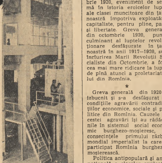
În secția sticlăriei, de curînd intrată în funcțiune, de la fabrica „Electrofer” din Capitală.
