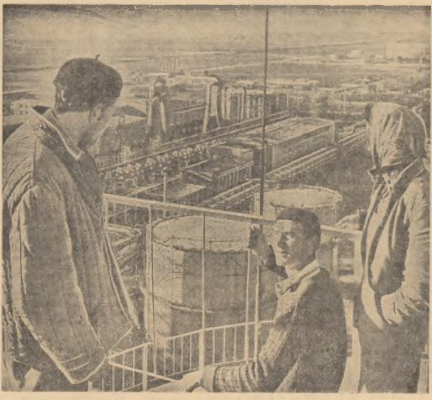
O discuție despre viitor pe platforma nivelului 63 la șantierul Combinatului Chimic din Roznov.
