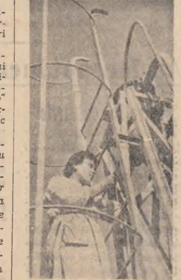
Ing. Lucia Petricescu de la Uzinele Chimice „9 Mai“ controlînd etanșeitatea la condensatorul barometric la instalarea de filtrare sub vacuum.
