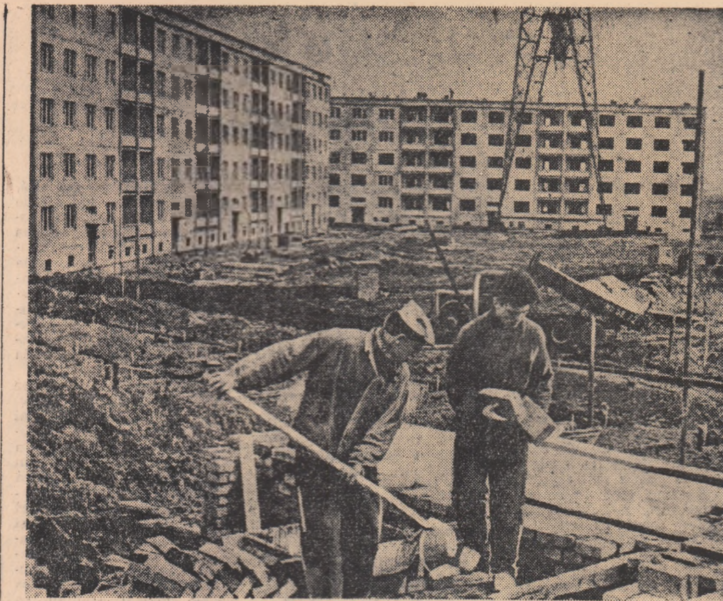
Studentii din R. S. Cehoslovacă își desfășoară practica pe șantierul de construcții.
