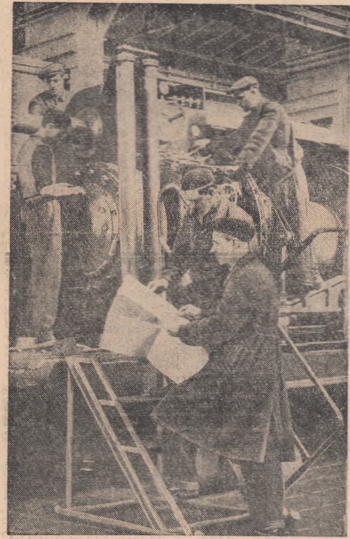
Brigada de montori condusă de maestrul Gh. Marin de la Uzinele „1 Mai” din Ploiești...
