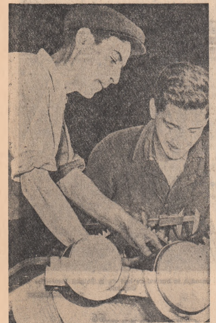
Da, așa e bine — îi spune Gheorghe Opran șeful unei echipe de la secția montaj-reductoare a Uzinelor „Mao Tze-tung“ din Capitală, tânărul montor Constantin Dărăștean, în timp ce montează roata dințată pentru podul rulant. Foto: S. NICULESCU
