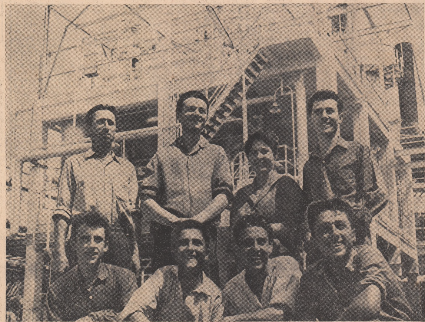
Tinerii din brigada lui Lucian Szekely de pe șantierul rafinării de la Brazi au de ce să fie mîndri. Ei cu terminat cu zece zile mai devreme lucrările la stația de 6 kv.
