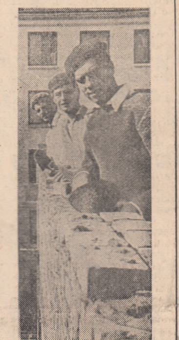
Tinerii zidari din brigada lui Florică Goleac de pe Șantierul de construcție a unui bloc din centrul Craiovei se numără printre constructorii fruntași. Foto: ADRIAN B.
