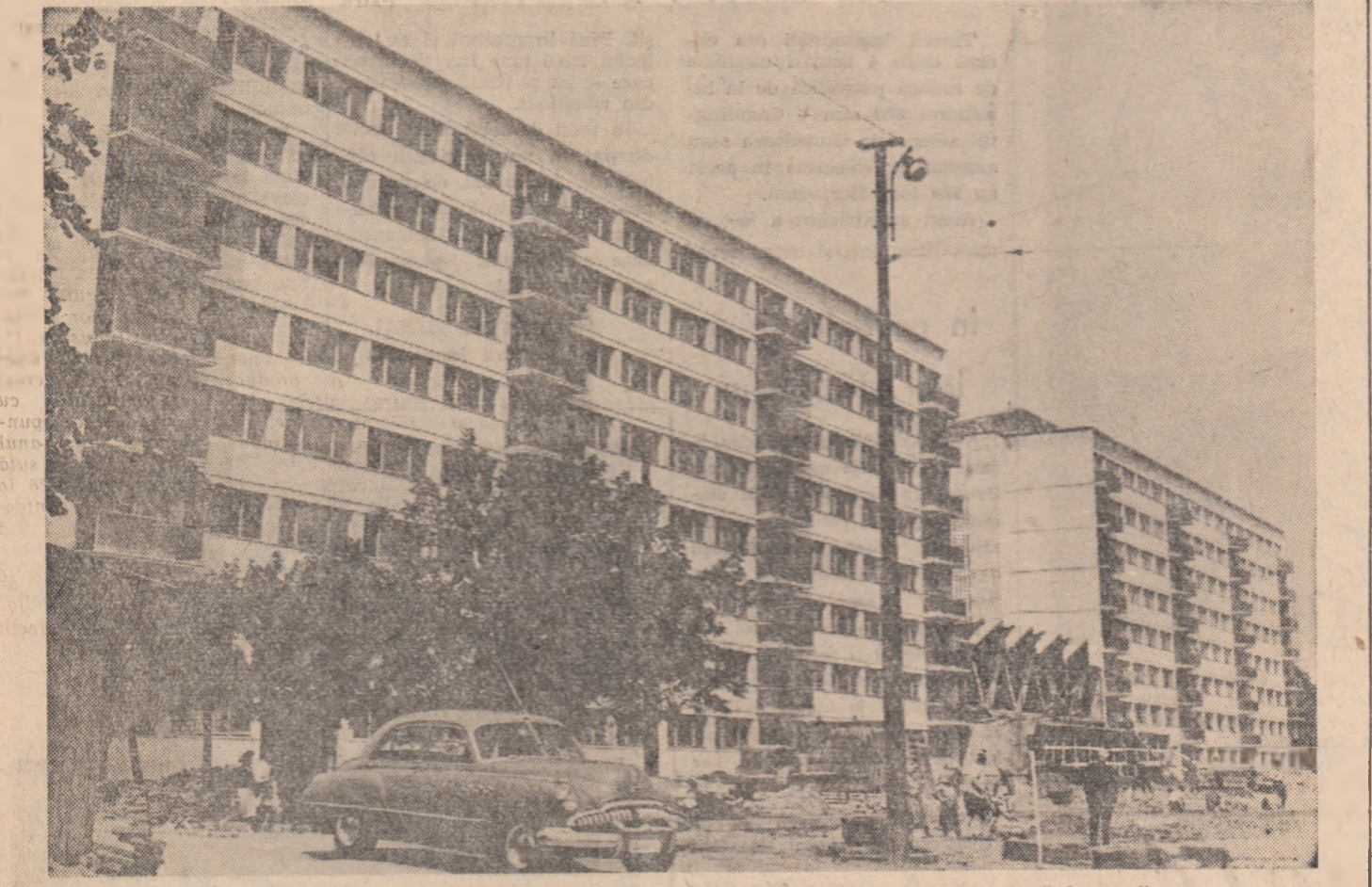
Pe șantierul Pieptănării din Capitală noi blocuri sînt gata să-și primească locatarii
