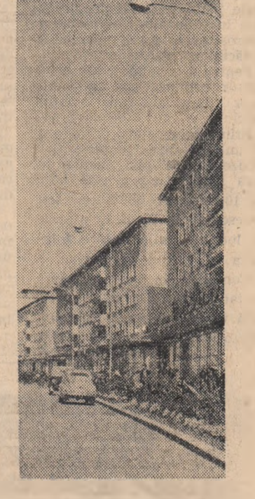
Construcții noi în centrul Ba. căului.
