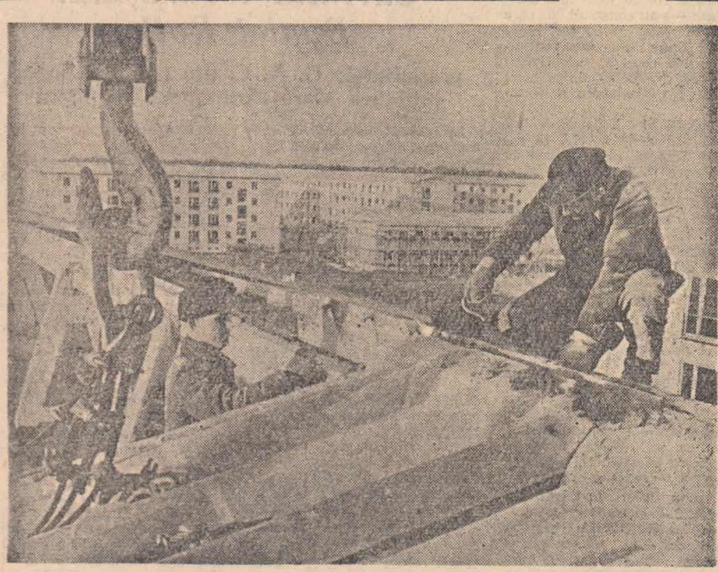
R. D. GERMANĂ. Membrii brigăzii de constructori din Neustadt Hoyerawerder și-au propus ca la fiecare 50 de apartamente să realizeze din economii un apartament în plus. Fotografia noastră înfățișează doi dintre membrii acestei brigăzi lucrând la acoperișul unui complex de locuințe din oraș.
