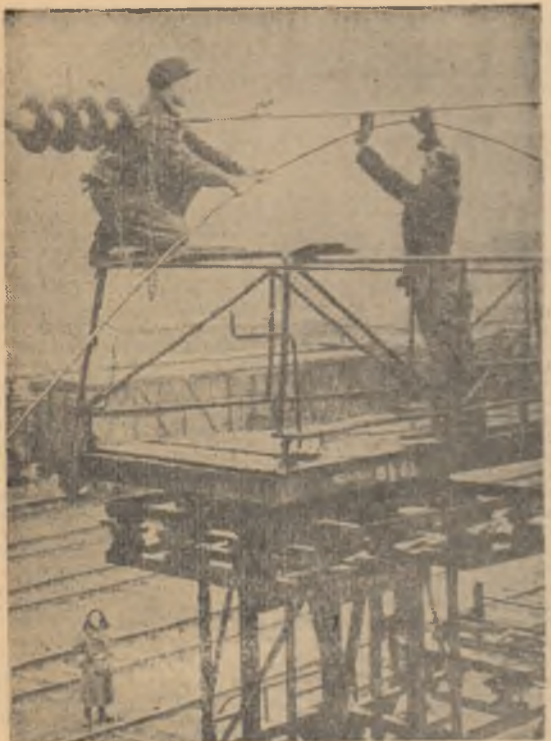
Lucrări pentru electrificarea liniei ferate sovietice Caucazul de nord
