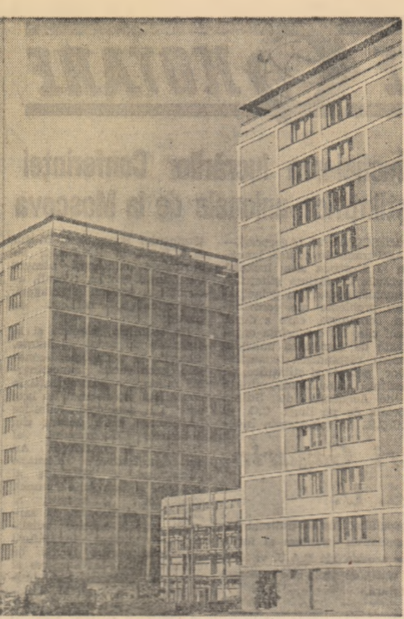
Și la Iasi, ca pretîndent în palma noastră, se construiește. Iată un șir de blocuri în stadiul de înălțare
